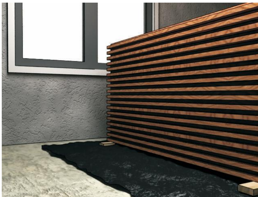
Produto armazenado corretamente com uso de lona plástica
